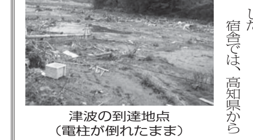
津波の到達地点(電柱が倒れたまま)
