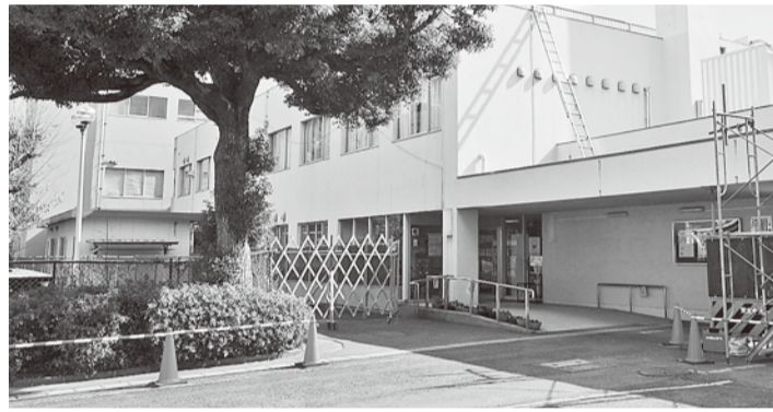
市への移管にむけ工事中の寝屋川保健所
